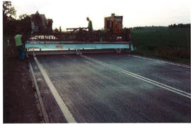
CSAH 25 2012 Concrete Overlay
