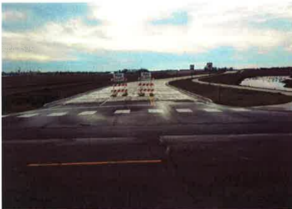
CSAH 41 2010-2011 New Construction
